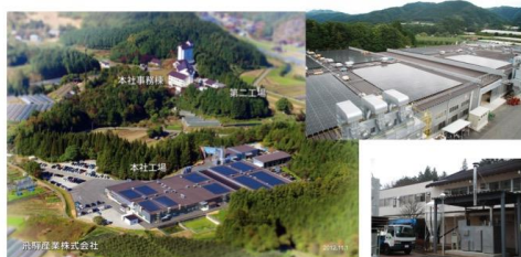
ペレットボイラーの導入
