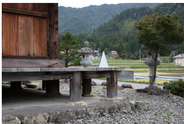
薬師堂 基礎部分
