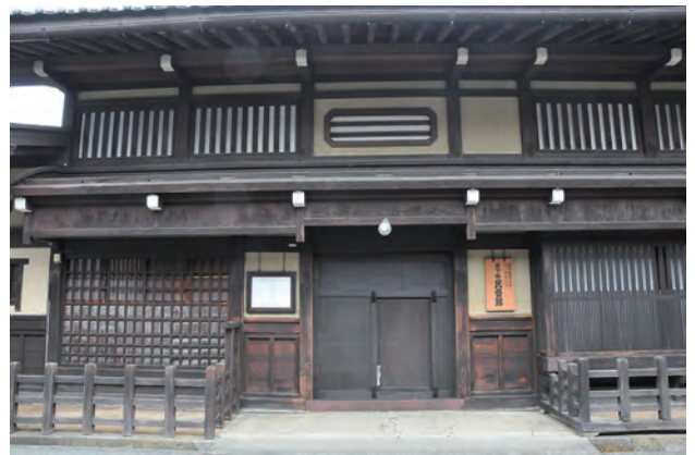
日下部民藝館 (国指定重要文化財)
