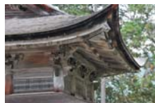
0223_安国寺経蔵 部分
