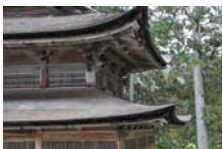
0226_安国寺経蔵 部分
