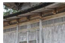
0234_安国寺経蔵 部分
