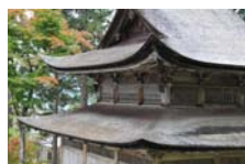
0233_安国寺経蔵 部分
