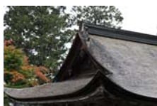
0232_安国寺経蔵 部分
