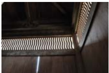
0216_安国寺経蔵 内部
