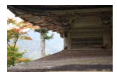
0245_安国寺経蔵 部分
