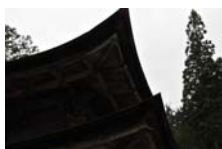
0237_安国寺経蔵 部分
