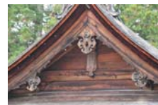
0229_安国寺経蔵 部分
