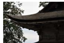
0224_安国寺経蔵 部分
