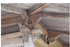
0241_安国寺経蔵 部分
