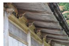
0239_安国寺経蔵 部分
