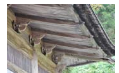
0240_安国寺経蔵 部分
