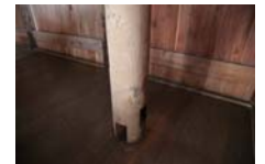
0220_安国寺経蔵 内部
