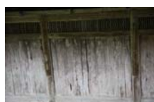
0248_安国寺経蔵 部分
