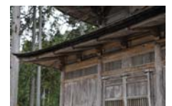
0235_安国寺経蔵 部分
