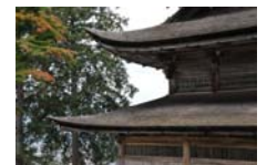
0225_安国寺経蔵 部分
