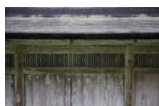
0243_安国寺経蔵 部分
