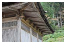
0238_安国寺経蔵 部分
