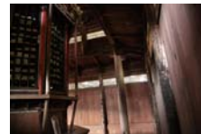
0219_安国寺経蔵 内部
