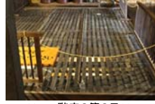
113_二階床の簀の子002
