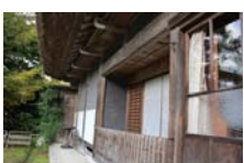
296_外観正面玄関004
