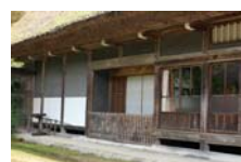
295_外観正面玄関003
