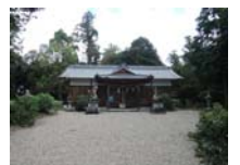
0070_檜隅寺跡(神社敷地)
