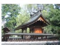
0078_檜隅寺跡(神社敷地)
