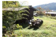
0119_長瀬家(光寿庵跡)の上部
