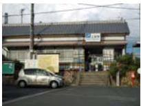
0011_手前の上狛駅周辺
