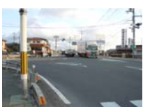
0021_手前の上狛駅周辺
