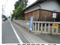
0008_五箇荘駅周辺・街道
