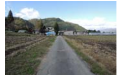
0055_遠景(西北から)
