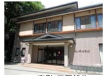
0015_南側・正面部分
