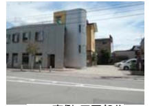
0005_南側・正面部分
