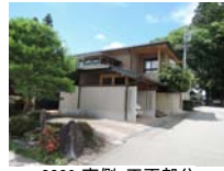
0009_南側・正面部分
