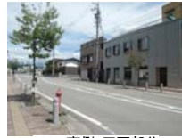
0004_南側・正面部分
