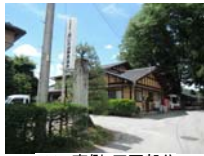
0012_南側・正面部分
