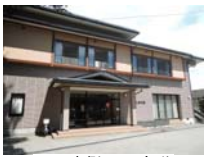
0016_南側・正面部分
