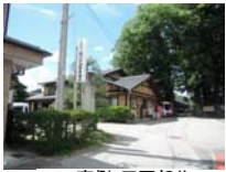
0011_南側・正面部分
