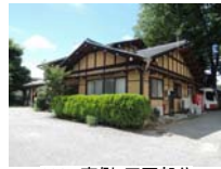
0014_南側・正面部分
