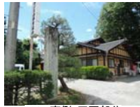
0013_南側・正面部分
