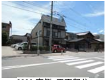
0006_南側・正面部分
