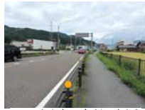
0008_中心部の高まり・東から
