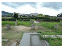
0032_水落遺跡・本体
