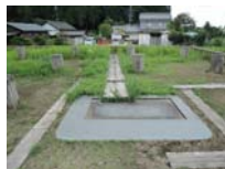
0023_水落遺跡・本体
