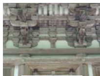
0028_三重塔・部分
