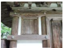
0021_三重塔・部分
