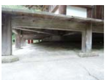
0041_三重塔・部分
