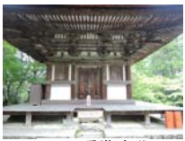
0016_三重塔・部分
