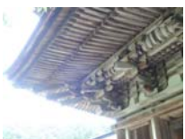
0036_三重塔・部分
