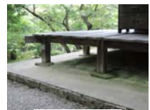
0030_三重塔・部分
