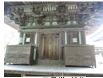
0014_三重塔・部分
