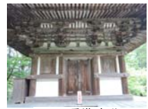
0020_三重塔・部分
