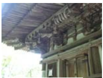
0026_三重塔・部分
