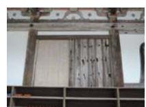
0050_三重塔・部分
