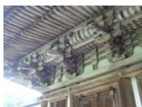
0037_三重塔・部分
