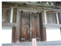
0023_三重塔・部分
