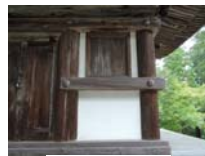
0024_三重塔・部分
