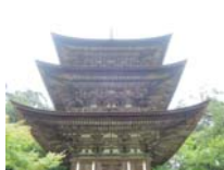
0047_三重塔・部分
