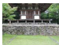
0049_三重塔・部分
