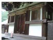
0033_三重塔・部分
