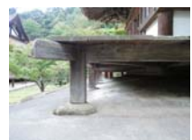
0040_三重塔・部分
