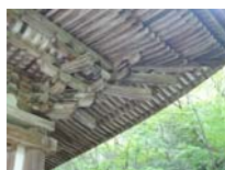
0038_三重塔・部分
