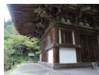
0039_三重塔・部分
