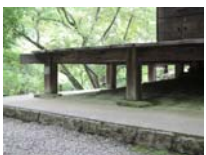
0031_三重塔・部分
