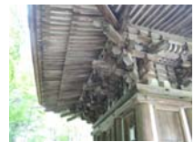
0025_三重塔・部分
