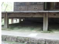
0032_三重塔・部分
