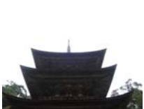
0046_三重塔・部分
