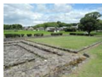
0032_板蓋宮・近景
