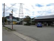
0094_西方からの遠景
