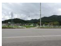
0083_西南からの遠景
