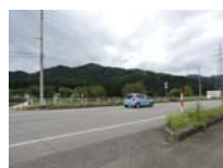
0084_西南からの遠景
