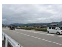
0099_西方からの遠景
