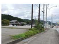
0097_西方からの遠景
