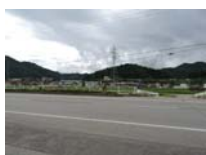
0082_西南からの遠景
