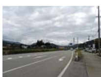
0092_西方からの遠景
