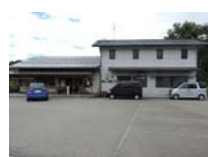
0095_西方からの遠景
