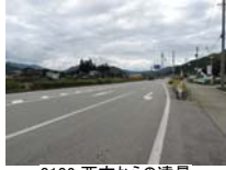
0102_西方からの遠景
