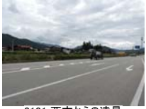
0101_西方からの遠景
