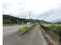
0085_西南からの遠景
