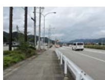
0098_西方からの遠景
