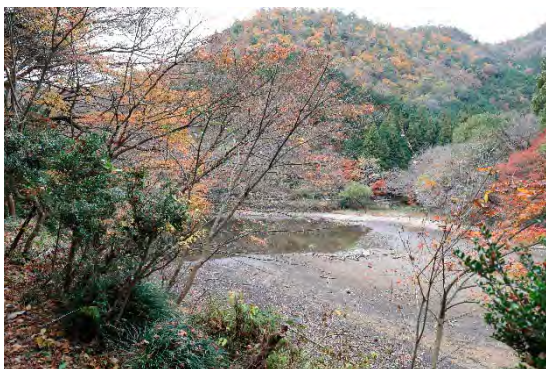
松尾池 林道側からの撮影
