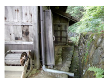
075_⑤新井家・建物まわり033
