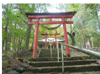
012_東照宮・本地堂19本地堂と鳥居
