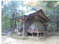
004_東照宮・本地堂11本地堂右側面
