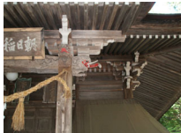
002_東照宮・本地堂10本地堂の軒下
