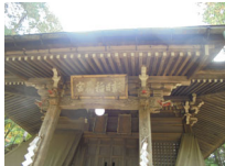
003_東照宮・本地堂10本地堂上部
