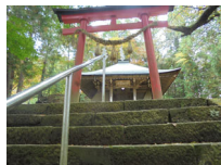
011_東照宮・本地堂18本地堂と鳥居
