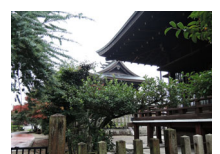
280_③伏見市内・全遺構伏見・乃木神社007
