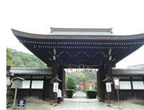
274_③伏見市内・全遺構伏見・乃木神社001
