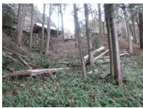
218_金龍神社修理完成(2015.12.29)016
