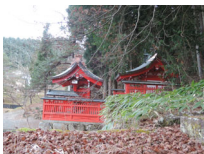
214_金龍神社修理完成(2015.12.29)012
