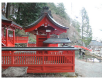
210_金龍神社修理完成(2015.12.29)008
