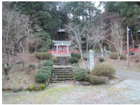
203_金龍神社修理完成(2015.12.29)001
