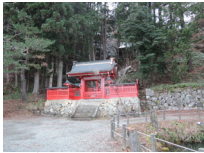
205_金龍神社修理完成(2015.12.29)003
