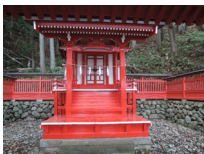
215_金龍神社修理完成(2015.12.29)013
