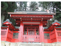
212_金龍神社修理完成(2015.12.29)010
