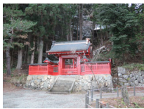
206_金龍神社修理完成(2015.12.29)004
