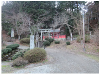
204_金龍神社修理完成(2015.12.29)002
