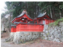
213_金龍神社修理完成(2015.12.29)011
