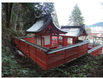
219_金龍神社修理完成(2015.12.29)017
