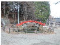
220_金龍神社修理完成(2015.12.29)018
