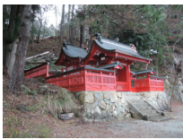
208_金龍神社修理完成(2015.12.29)006
