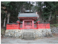
207_金龍神社修理完成(2015.12.29)005
