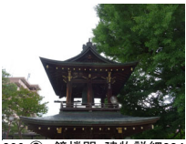
026_③ 鐘樓門・建物詳細004
