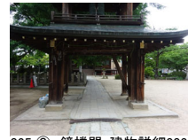
025_③ 鐘樓門・建物詳細003
