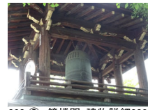
030_③ 鐘樓門・建物詳細008
