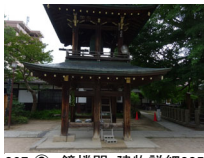
027_③ 鐘樓門・建物詳細005
