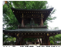
024_③ 鐘樓門・建物詳細002
