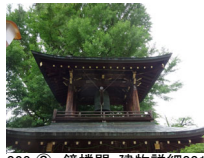
023_③ 鐘樓門・建物詳細001
