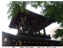
028_③ 鐘樓門・建物詳細006
