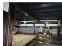
040_④内部吹き抜け009
