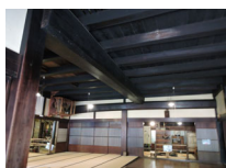
036_④内部吹き抜け005
