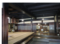
032_④内部吹き抜け001
