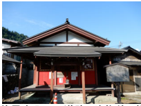
056_②慈恩寺入口の道路、建物前の様子031057
