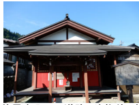
057_②慈恩寺入口の道路、建物前の様子032058
