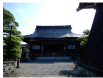
068_②慈恩寺入口の道路、建物前の様子043069
