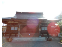
069_②慈恩寺入口の道路、建物前の様子044070
