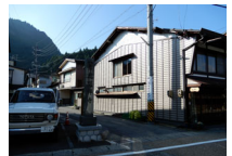
036.②慈恩寺入口の道路、建物前の様子011
