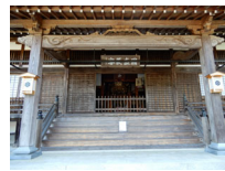
070_②慈恩寺入口の道路、建物前の様子045
