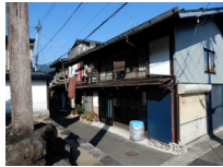
052_②慈恩寺入口の道路、建物前の様子027053
