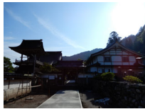
062_②慈恩寺入口の道路、建物前の様子037063
