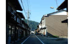
025.②慈恩寺入口の道路、建物前の様子000
