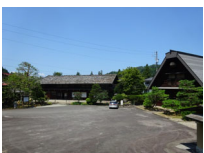
031_③荒川家・外観その2005
