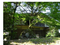
029_③荒川家・外観その2003
