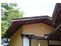
242_⑨荒川家・土蔵外観006
