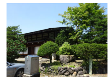
030_③荒川家・外観その2004
