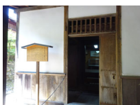
237_⑨荒川家・土蔵外観001
