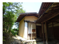
240_⑨荒川家・土蔵外観004
