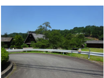
046_④荒川家・外観その3014
