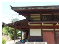
037_④荒川家・外観その3005
