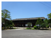
027_③荒川家・外観その2001
