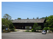
032_③荒川家・外観その2006
