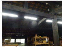
209_①荒川家・2階その4023
