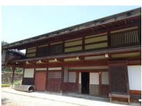
036_④荒川家・外観その3004
