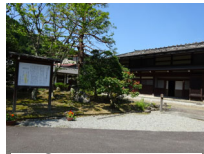
012_①荒川家・外観その1012
