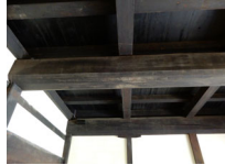
207_16三島家・玄関、才工周辺、梁017
