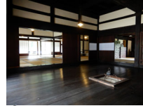
204_16三島家・玄関、才工周辺、梁014
