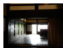
200_⑯三島家・玄関、才工周辺、梁010
