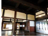
202_16三島家・玄関、才工周辺、梁012
