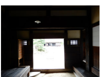
196_⑯三島家・玄関、才工周辺、梁006
