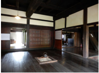
206_16三島家・玄関、才工周辺、梁016
