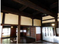
201_16三島家・玄関、才工周辺、梁011
