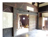
195_⑯三島家・玄関、才工周辺、梁005
