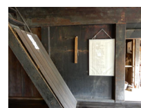
194_⑯三島家・玄関、才工周辺、梁004
