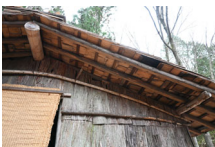
036_⑥杣小屋外観009
