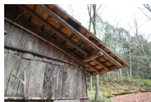
037_⑥杣小屋外観010
