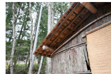
034_⑥杣小屋外観007
