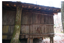
033_⑥杣小屋外観006
