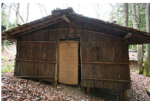
031_⑥杣小屋外観004
