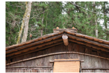
029_⑥杣小屋外観002
