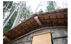
035_⑥杣小屋外観008
