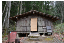
028_⑥杣小屋外観001
