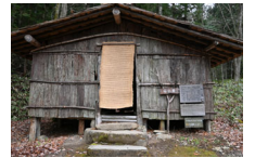
030_⑥杣小屋外観003
