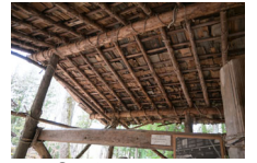
015_③木挽き小屋屋根裏002
