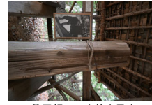
009_②屋根下の木挽き見本001
