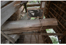
011_②屋根下の木挽き見本003
