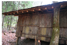
032_⑥杣小屋外観005
