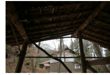
014_③木挽き小屋屋根裏001
