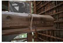
012_②屋根下の木挽き見本004
