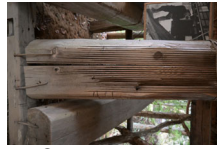
013_②屋根下の木挽き見本005
