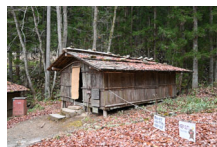
038_⑥杣小屋外観011
