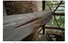
010_②屋根下の木挽き見本002
