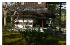
291_③銀閣寺⑱銀閣寺建物側面002
