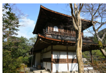
293_③銀閣寺⑱銀閣寺建物側面004
