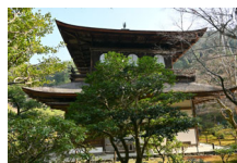
294_③銀閣寺⑱銀閣寺建物側面005
