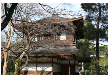
292_③銀閣寺⑱銀閣寺建物側面003
