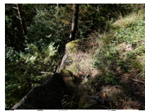
134_㊟石垣その3(天場)010
