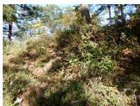
137_㊟石垣その3(天場)013
