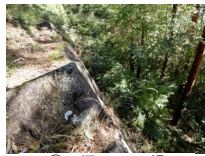
128_㊟石垣その3(天場)004
