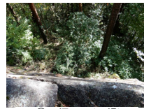
130_㊟石垣その3(天場)006
