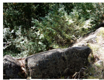
133_㊟石垣その3(天場)009
