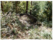
126_㊟石垣その3(天場)002
