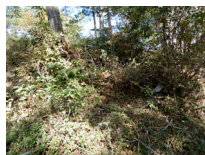
138_㊟石垣その3(天場)014
