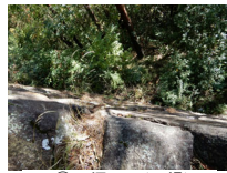
129_㊟石垣その3(天場)005
