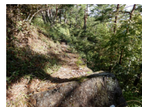
140_㊟石垣その3(天場)016
