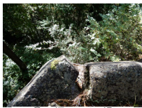
132_㊟石垣その3(天場)008
