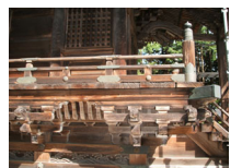
070_58本殿左角手すり下
