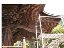
078_63左側から軒下を見る
