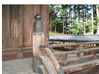
072_59階段手すり 右
