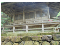
027_20 本殿の左となりの建物
