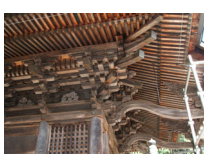
077_62左側から軒下を見る(2)
