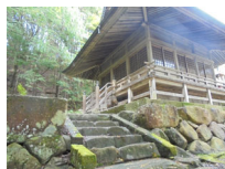
028_21 本殿の左となりの建物
