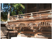
076_61左側手すり下
