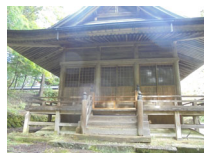
029_22 本殿の左となりの建物
