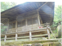
026_19 本殿の左となりの建物
