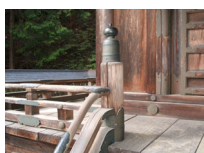
073_59階段手すり 左
