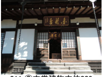
011_②本堂建物本体009
