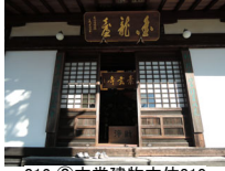
012_②本堂建物本体010
