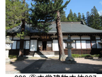
009_②本堂建物本体007
