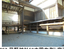
057_荇野神社52本殿左側と廊下
