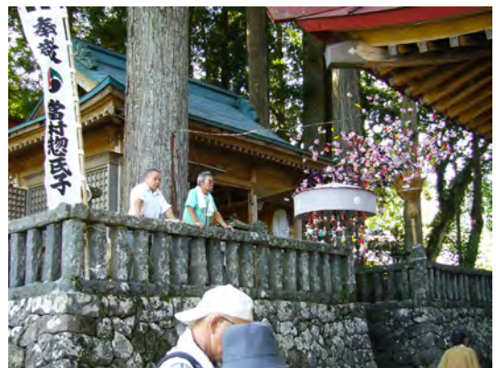
2-6-4 石積と幣殿（社務所）
