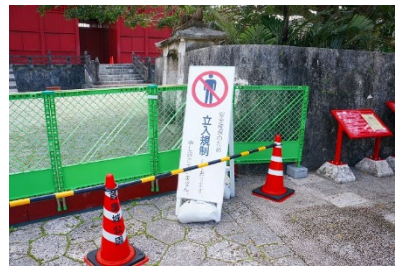
安全柵で囲まれた奉神門エリア 「立入禁止」の看板
