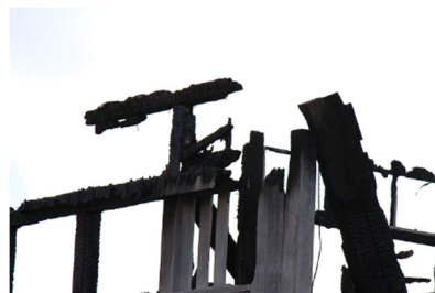
激しく燃えた屋根の一部
