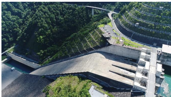
写真5 徳山ダム(堤高161.0m) 2019/9,岐阜
