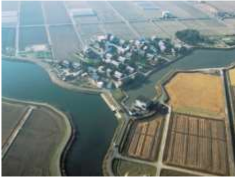
輪中堤排水機場の空撮画像
