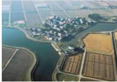
輪中内の排水機上空
