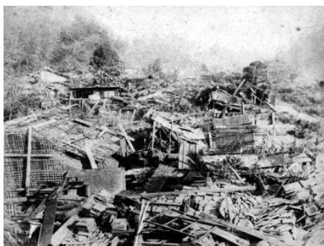
濃尾地震の被害の様子
