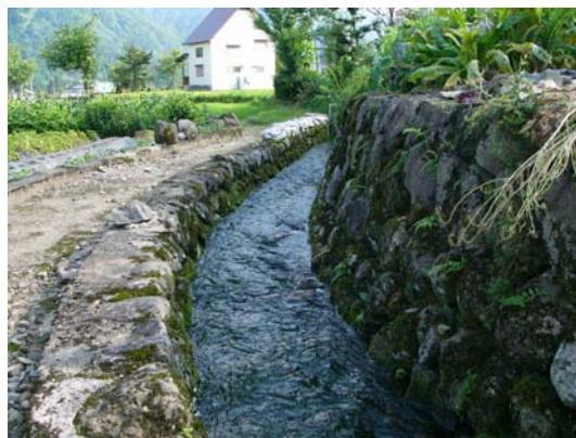
石積みでつくられた水路
