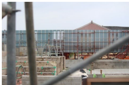
残された階段と正殿の柱礎石
